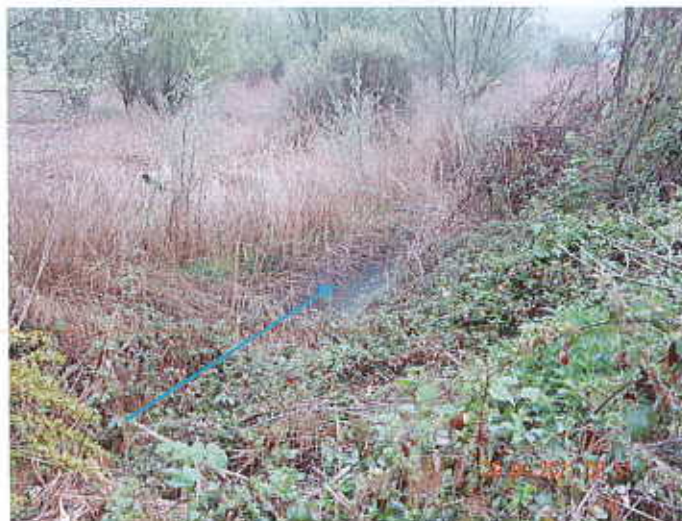
Photo 5. Etat d'enherbement et mise en évidence du faible dimensionnement du Chenal de chasse.
