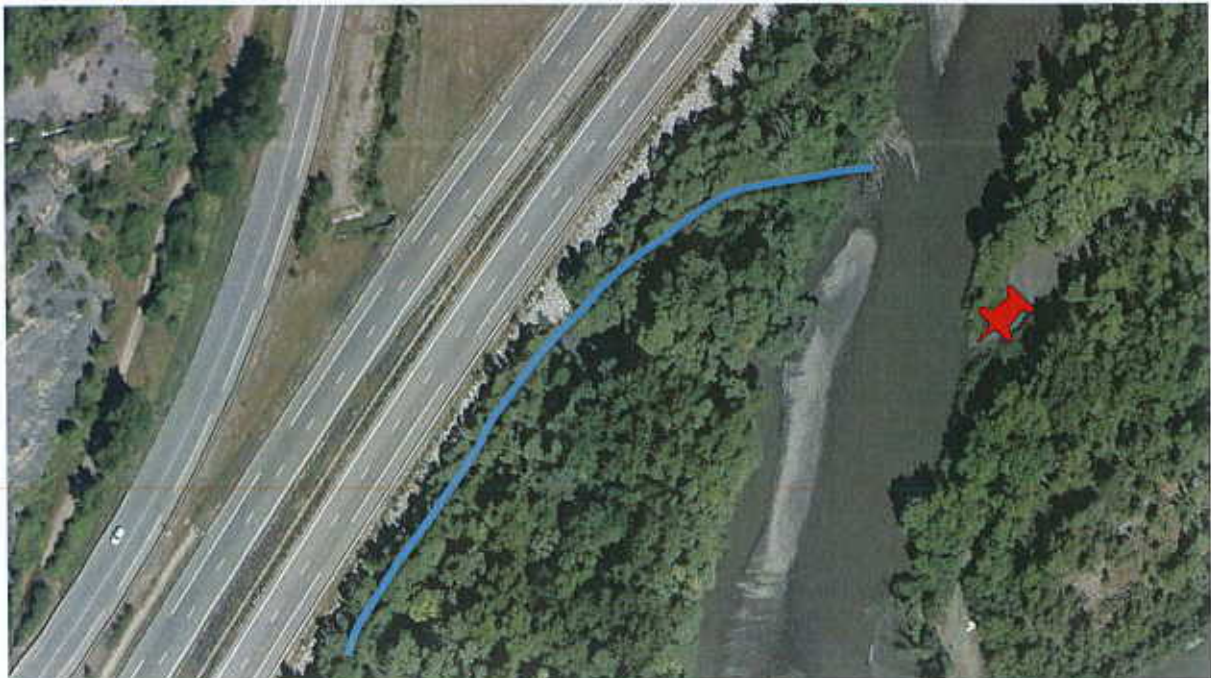
Photos prise en 2018, aucun entretien n'a été fait par EDF jusqu'à ce jour, le chenal A de la Durance est schématisé
