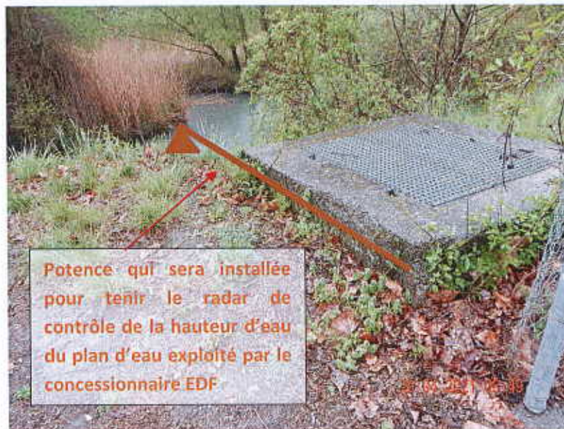
Photo 3. Représentation graphique de la potence et du radar qui seront installés pour contrôler le niveau de la Durance en ce point et par la même la bonne alimentation du Canal du Moulin et disposer de preuves
