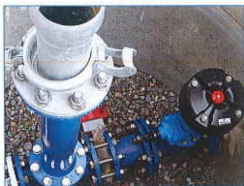
Photo 3. Point d'accès aux eaux en aval du point de livraison
