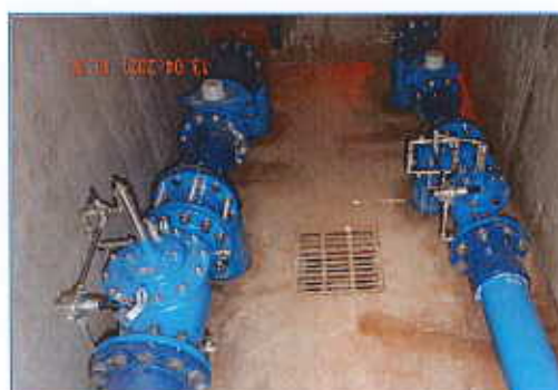
Photo 2. Intérieur de la chambre de vanne et vue sur les équipements de points de livraison d'eau (vannes, régulateur de pression, limiteurs de débits et compteurs). Point de livraison « grandes propriétés » de 22 ha pour monsieur Arieys et de 10 Ha pour monsieur Marrou.
